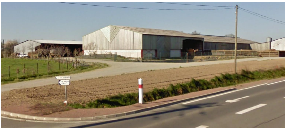
Figure 24 : Façade sur la RD 160 en direction de la Merlatière : bâtiment d'élevage existant conservé par le projet.
