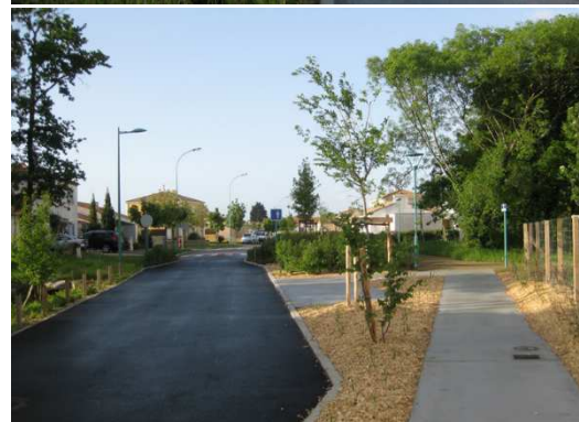
Voie de desserte, rue de quartier, différentes ambiances sont possibles, mais la largeur de chaussée est plus petite et les sorties directes sont limitées
